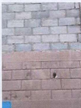
Foto 3: REPARACION DE MURO PERIMETRAL
