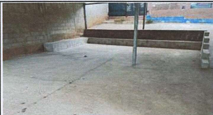
Foto1: CORRECCION DE NIVELES EN PATIO
